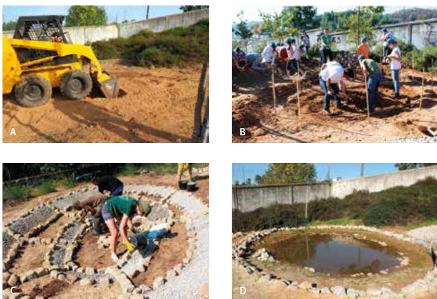
FIGURA 2 A: escavação da cova inicial com máquina; B: definição do perfil do charco com ferramentas manuais; C: revestimento do leito e criação de microhabitats; D: charco dois meses após a implementação, em processo de naturalização.
