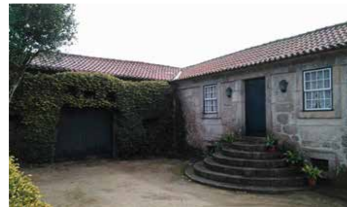
FIGURA 27 Imagens da Casa do Carreiro de Baixo
