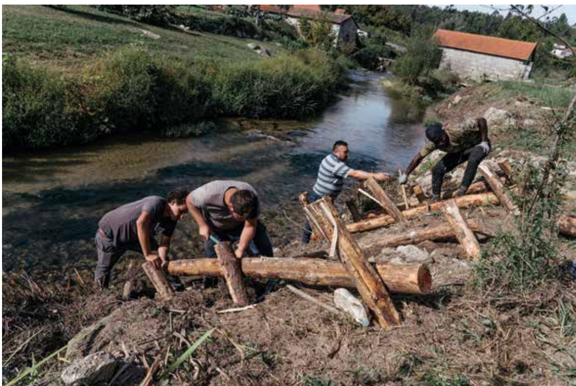
FIGURA 36 Projeto ReValSOUZA: Fase 1 – Modelação de margens e recuperação do corredor ribeirinho e trabalhos biofísicos (©Jorge Barbosa).
