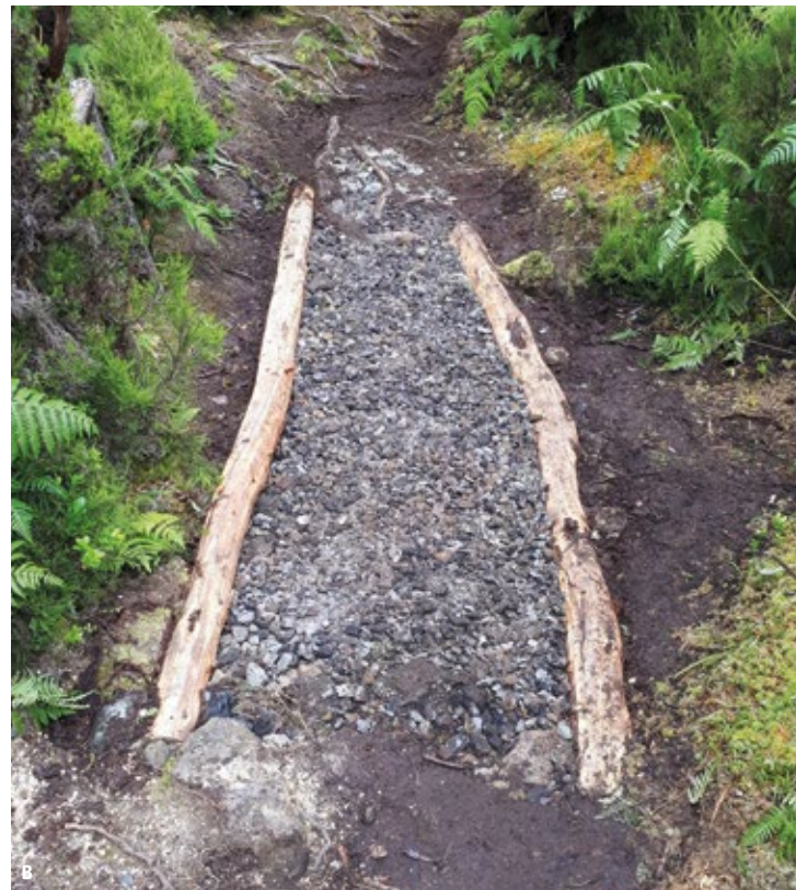
FIGURA 7 Construção de pisos elevados. A – processamento de rocha local para fazer o enchimento; B – estrutura terminada.
