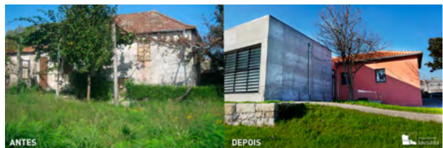
FIGURA 9 Recuperação de edifício devoluto no Parque Urbano. Atual Centro de Educação Ambiental Casa das Videiras.
